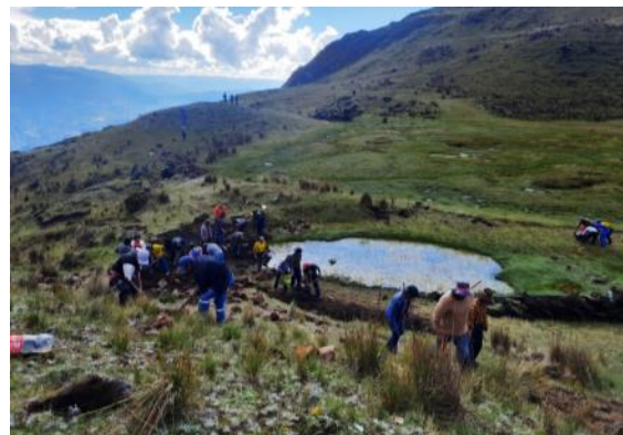
1 Rehabilitación y mantenimiento de represas (Qochas) en Apurímac.
